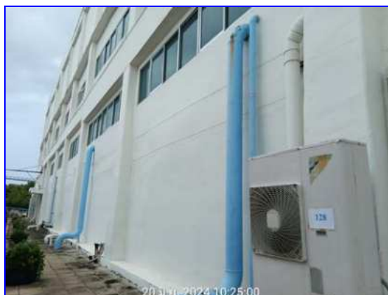
รูปที่ 2.9 ระบบระบายน้ำฝน
